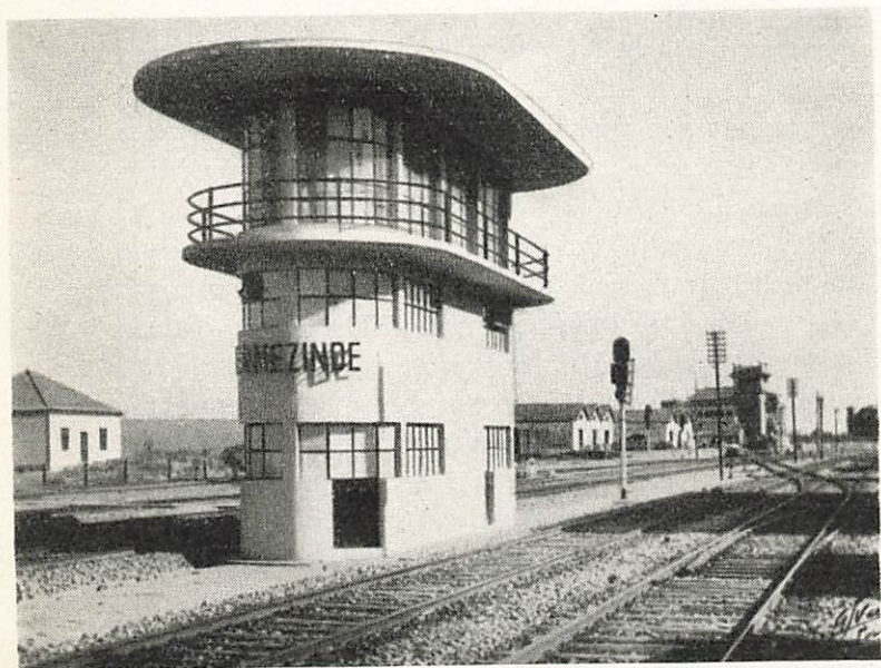
Fig. 2. Ställverkshuset i Ermezinde, Portugal.
