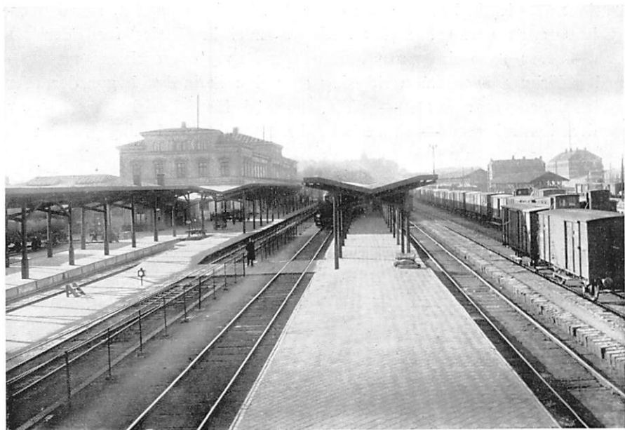
Fig. 44. Personplattformerna B:s Göteborg.
