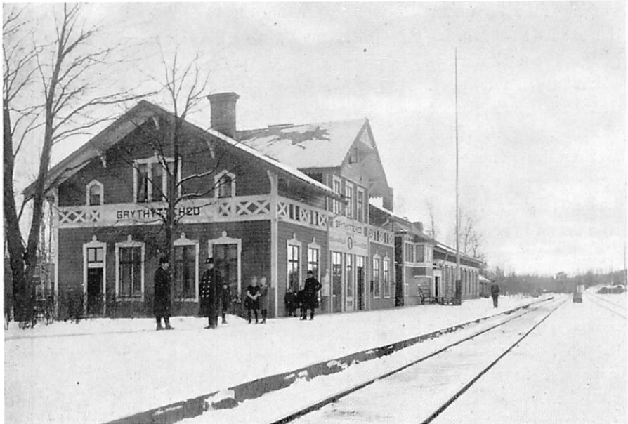
Fig. 47. Grythyttedals stationshus, sammanbyggt med ställtverk.
