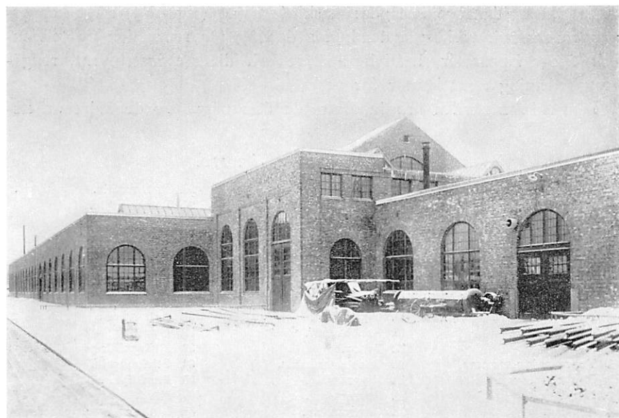
Fig. 112. Nya verkstaden, gårdssida.
