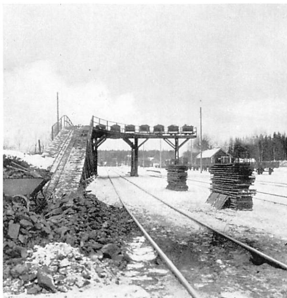
Fig. 96. Kolgivningsbrygga i Daglösen .
