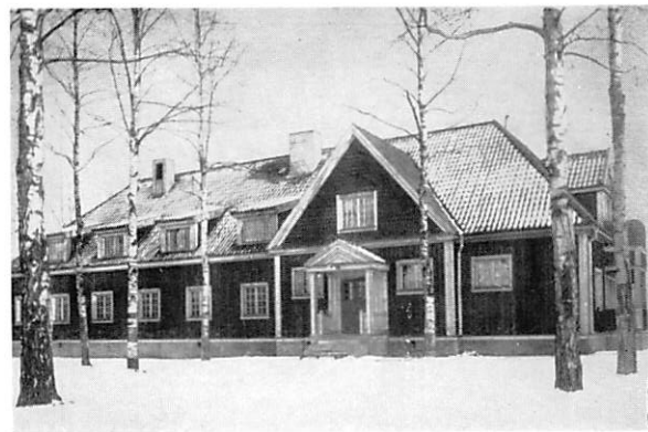
Fig. 145. Överliggningsbyggnaden i Ludvika.
