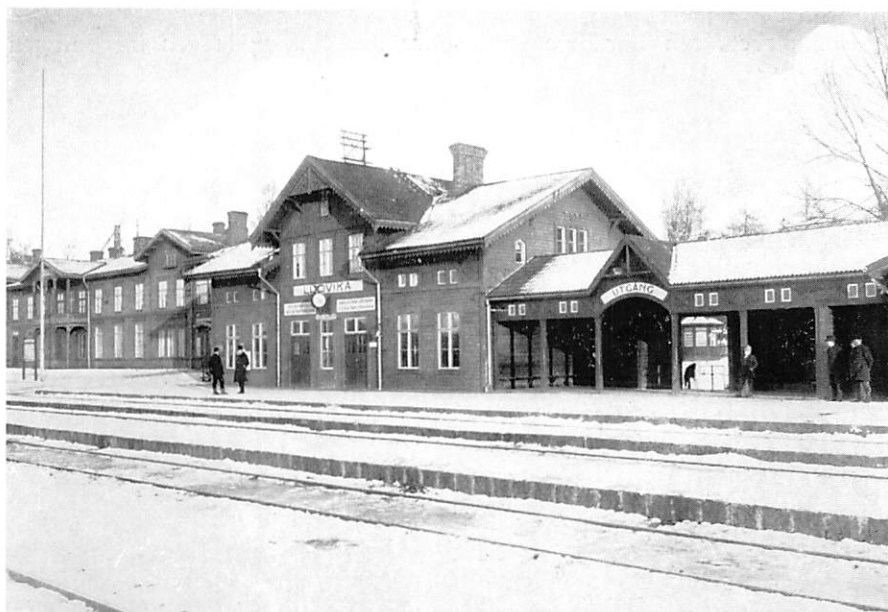
Fig. 72. Ludvika stationshus efter tillbyggnad.
