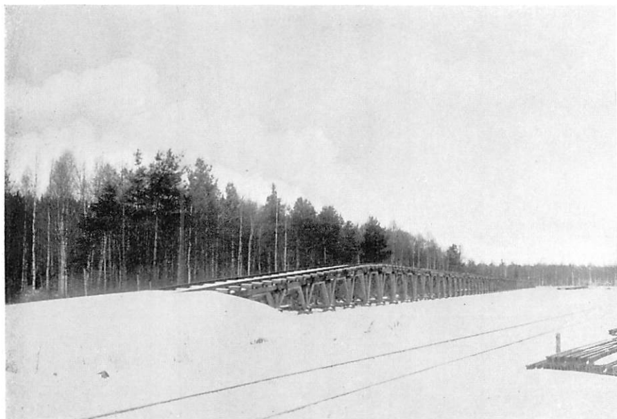
Fig. 95. Kollossningsbrygga i Grythytted.
