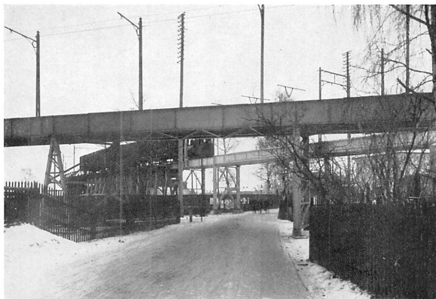
Fig. 213. Viadukter över B. J. vid Borlänge.
