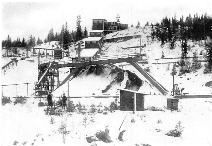
Fig. 215. Rämshytte bruks anrikningsverk.
