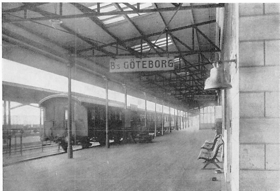
Fig. 231. Personplattform i Göteborg.
