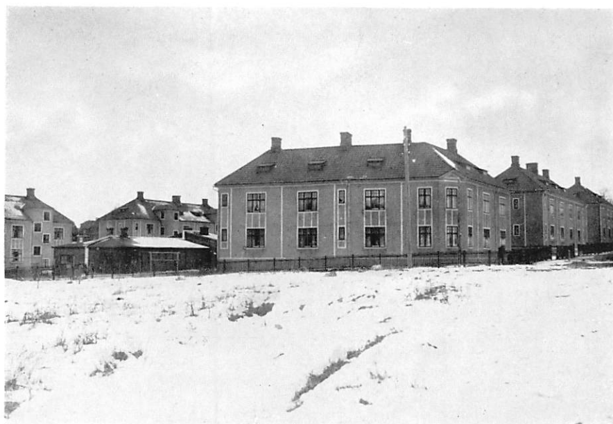
Fig. 237. Pensionskassans byggnader i Åmål.
