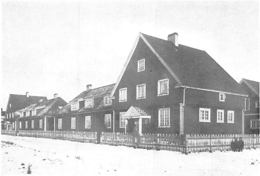
Fig. 233. Pensionskassans byggnader i Ludvika.
