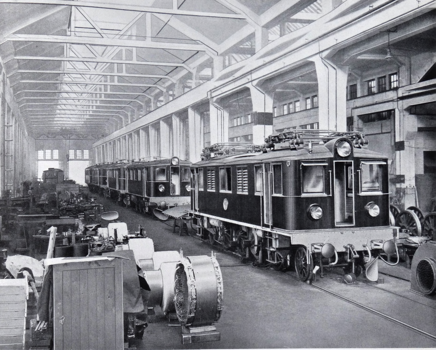
Locomotoras eléctricas en curso de montaje
