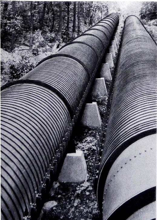
Tubería de duelas de madera atravesando un río
