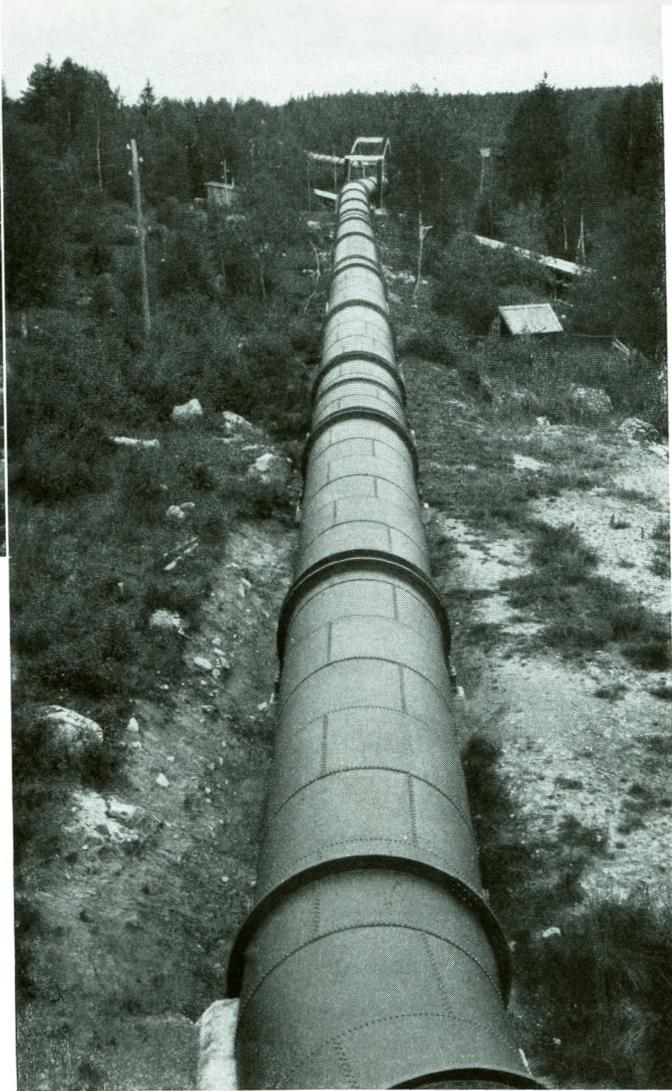
Tubería remachada de chapa de acero
