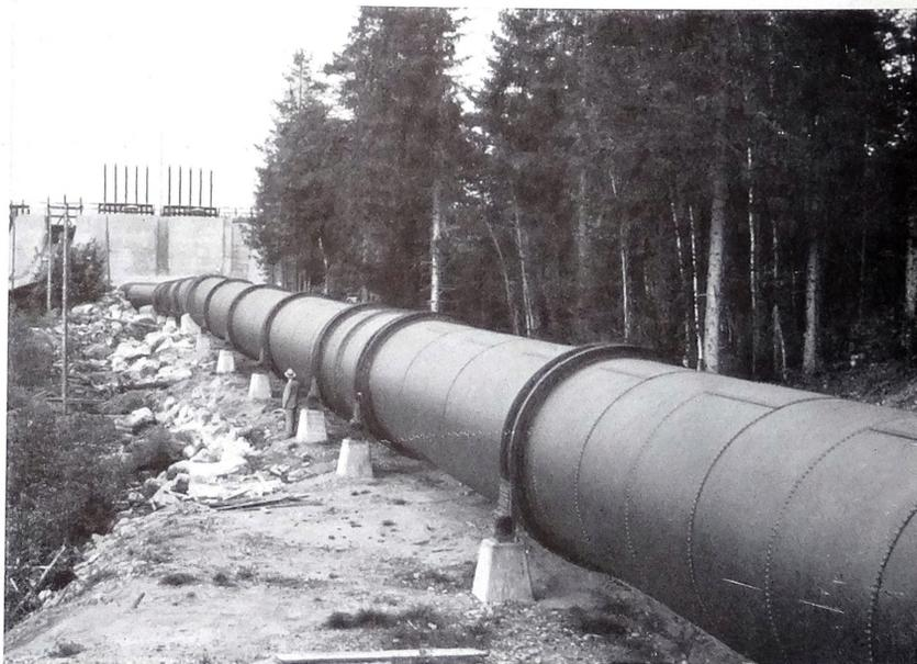
Tubería de chapas de acero remachadas, diámetro interior 2,85 metros; caudal: 16 metros cúbicos por segundo
