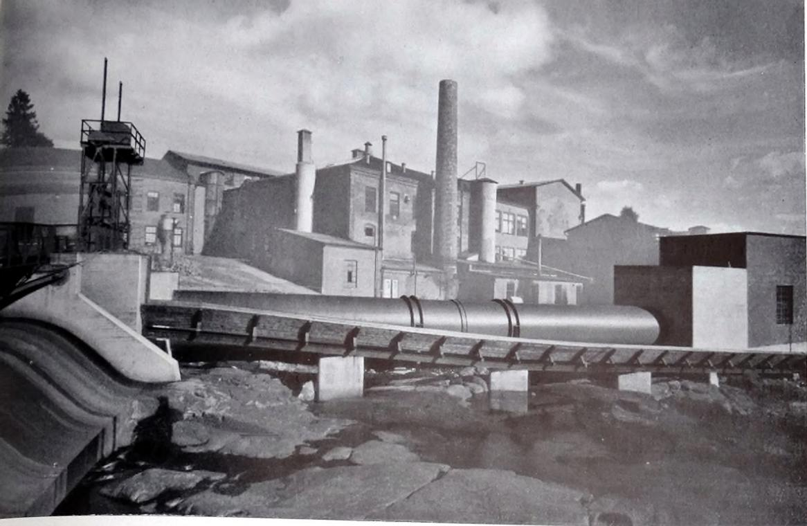
Tubería de chapas de acero soldadas, diámetro interior 3,2 metros; por ella pasan 12,5 metros cúbicos por segundo. (La compuerta de esclusa de la entrada y la compuerta de sectores para la represa de regulación también se entragaron por NOHAB)
