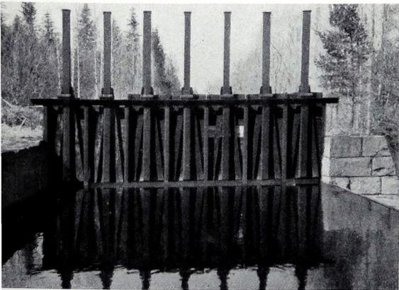
Compuerta de entrada al canal de llegada (puertas de madera)
