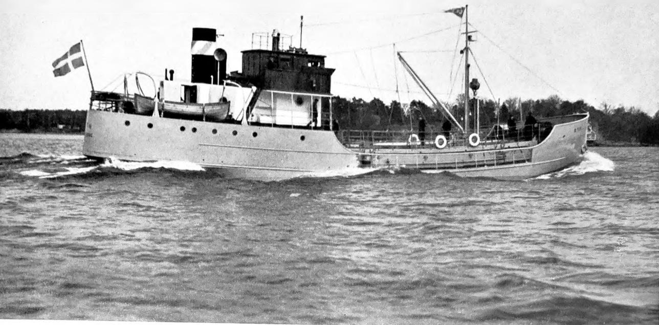
Barco tanque sueco "B. T. III" de la compañía Aktiebolaget Bensintransport, Estocolmo. La maquinaria propulsora comprende un motor Diesel NOHAB, tipo MG-5, de 300 HP a 300 r. p. m.
