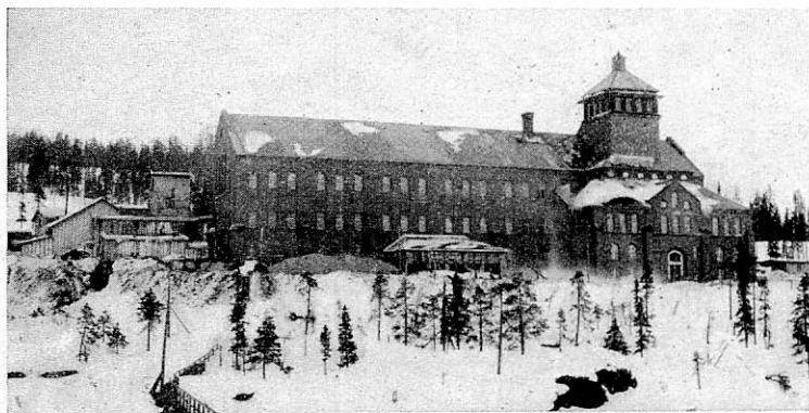
Bild 8. Porjus kraftverks ställverksbyggnad.
