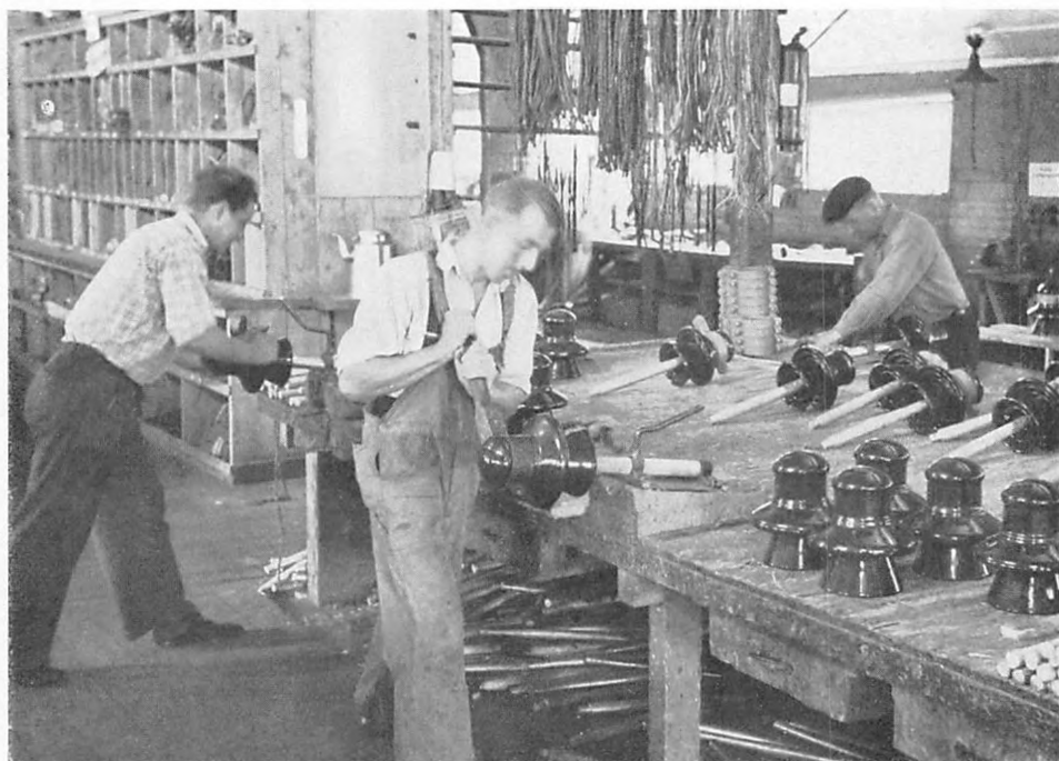
Drevning av isolatorer i elektrifieringsförrådets montagehall.
