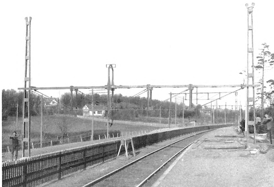
Ledningsbrygga över bangård hissas upp med hjälp av specialkonstruerade spel.
