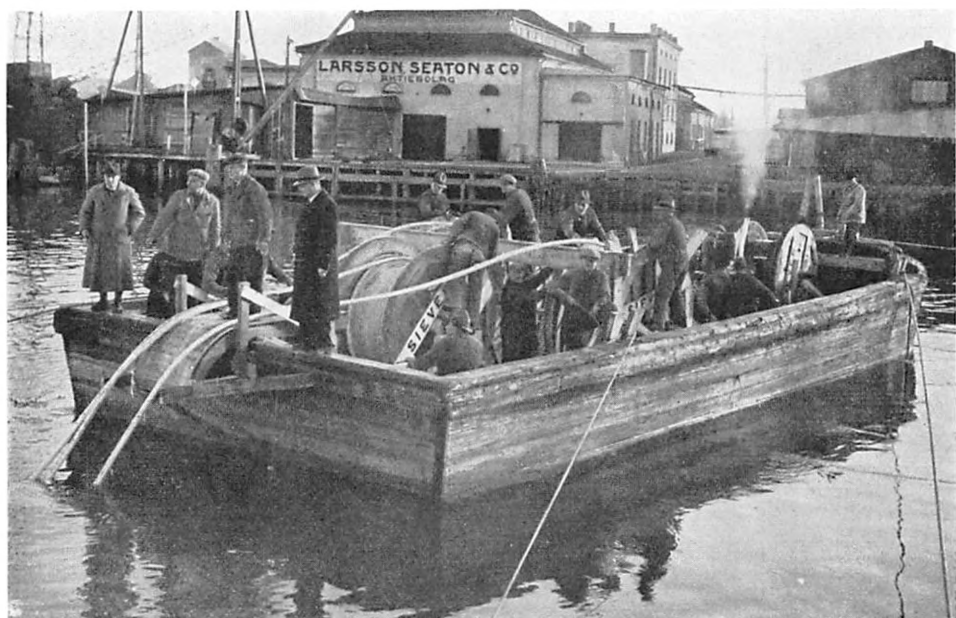
Kabelläggning över vattendrag.
