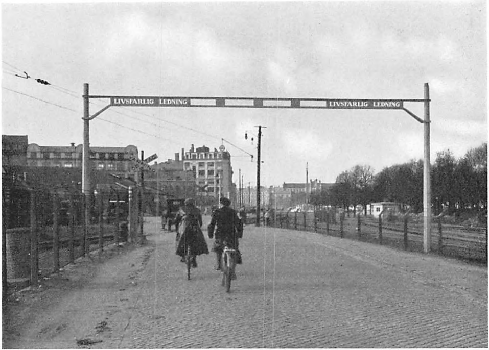
Regelskydd uppsätts där elektrifierad järnväg korsar allmän väg i samma plan.
