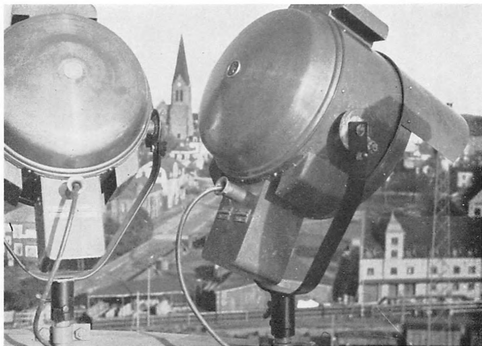
Strålkastare för bangårdsbelysning, monterade i toppen av 30 m hög strålkastarmast.
