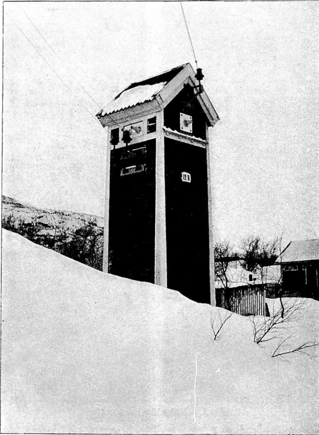
Bild 14. Skyddshus för kontaktledningen med transformator för stationsbelysning.
