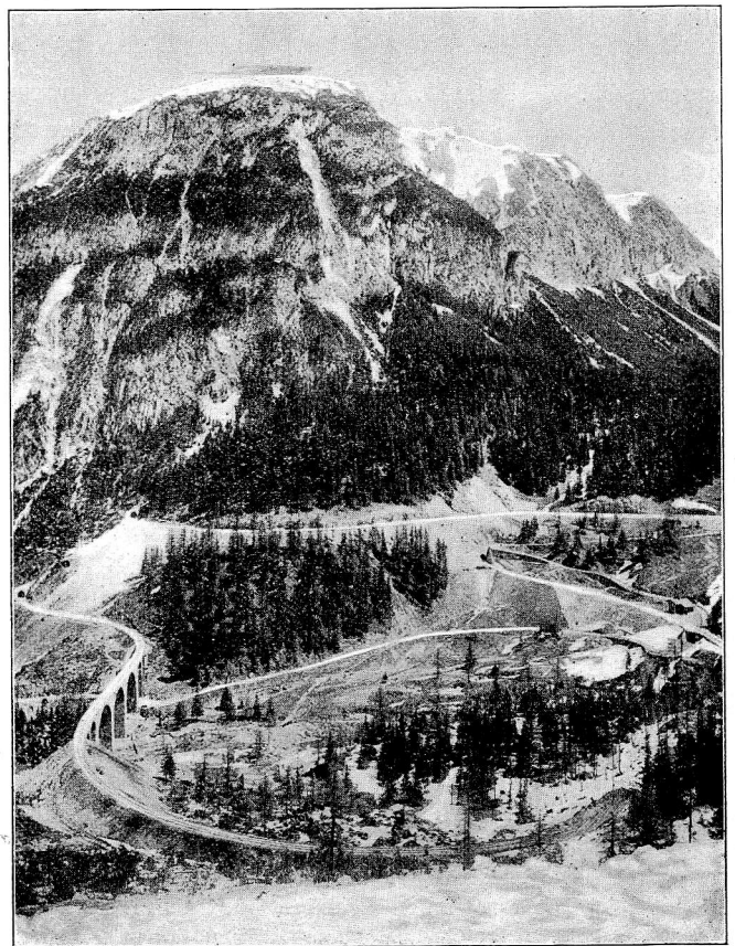
Abb. 7. Bahnentwicklung unterhalb Preda und Albulastraße. Toua- und Zuondra-Kehtunnel. III. Albulabrücke.
