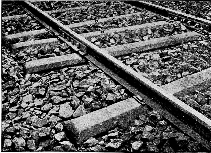
Abb. 14. 25 mm große Wärmelücke bei dem gewanderten Blattstofs.
