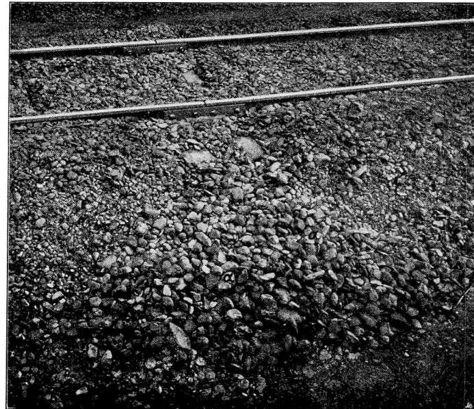
Abb. 18. Wanderndes 1½ Jahr altes Stemmlaschengleis. Schrägwurf des Stofses 8 cm.
