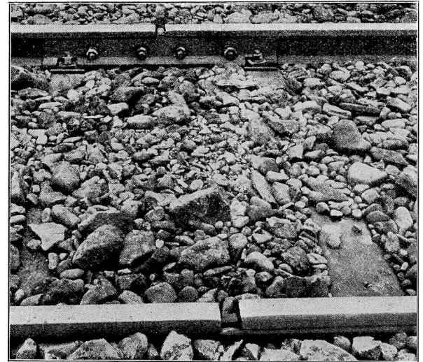
Abb. 16. Aufgerütteltes, hinabgerolltes Bettungsmaterial am Stofse. Schuttkegel a
