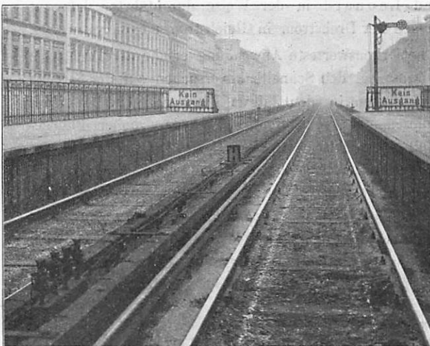
Abb. 8. Anordnung der dritten Schiene bei der Hoch- und Untergrundbahn in Berlin.
