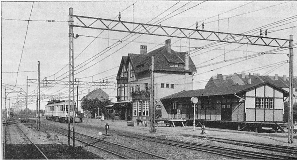
Abb. 11. Rheinuferbahn Köln-Bonn, 1000 Volt Gleichstrom. Fahrleitungsanlage im Bahnhof. (S. S. W.)
