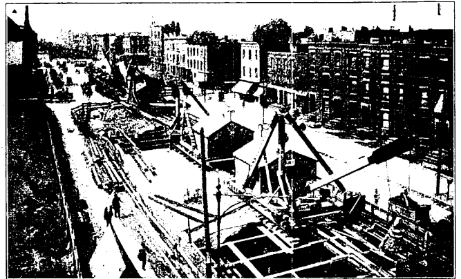
Abb. 18. Baustelle der IV. Avenue-Untergrundbahn in Brooklyn, in der Nähe der Warren-Straße.
