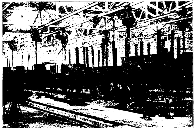
Abb. 3. Anordnung elektrischer Flaschenzüge zum Heben von Güterwagen.
