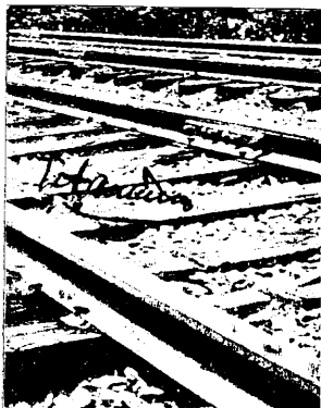
Abb. 1. Schienen aus Titanstahl.
