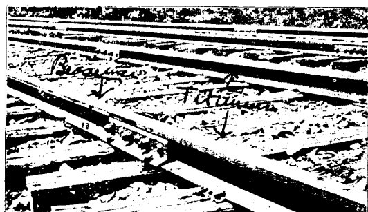
Abb. 4. Untere rechte Schiene aus Titan-Stahl, untere linke Schiene aus Normal-Bessemer-Stahl.
