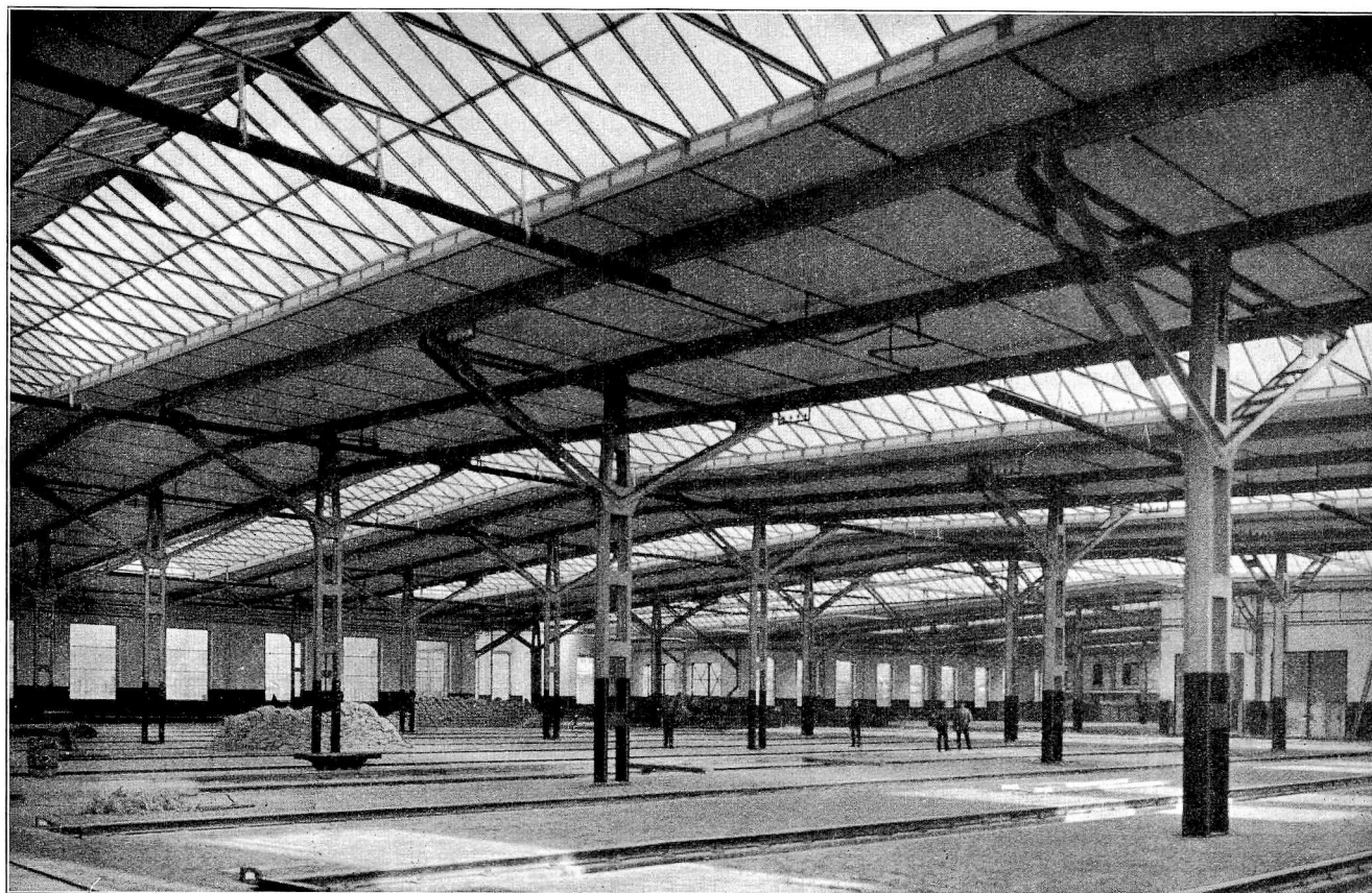
Abb. 2. Die Ausbesserungshallen der neuen Wagen-Werkstätte.
