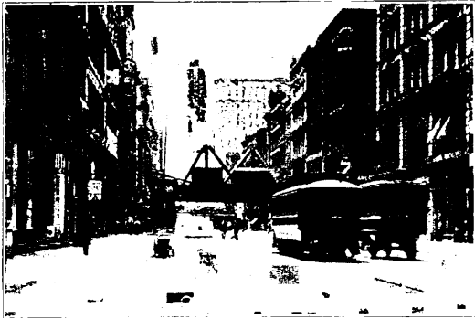
Abb. 14. Bau der Untergrundbahn im südlichen Broadway in Neuyork. Der Broadway an einem Sonntage. Im Hintergrunde ein Schacht mit Kran.
