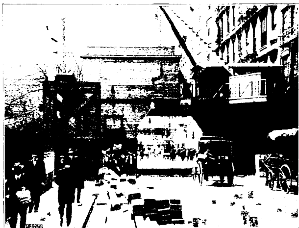
Abb. 16. Untergrundbahnbau in der Veseystraße in Neuyork. Schacht mit Schüttgerüst und Kran.
