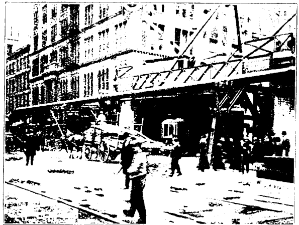
Abb. 13. Bau der Untergrundbahn im südlichen Broadway in Neuyork. Aushubschächte an der Kanalstrafse.
