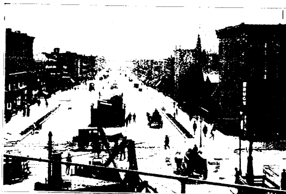
Abb. 25. Blick auf die Untergrundbahn mit Inseln zur Lüftung in der IV. Avenue in Brooklyn.
