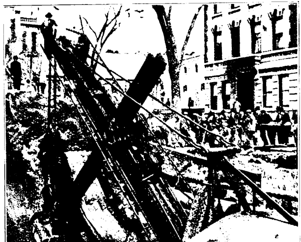
Abb. 20. Bau der Untergrundbahn in der IV. Avenue in Brooklyn. Erdaushub mit der Dampfschaufel.
