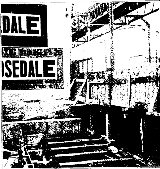
Abb. 24. Bau der Untergrundbahn in der IV. Avenue in Brooklyn. Tiefergründung des Majestic-Theaters an der Fultonstrasse.
