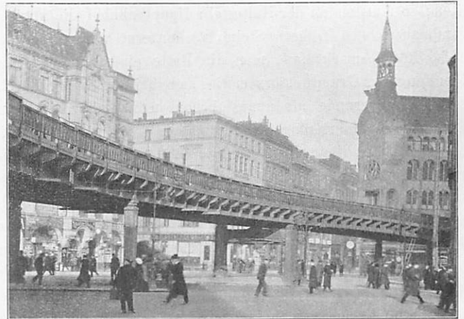
Abb. 4. Gekrümmter Hauptträger Rödingsmarkt.
