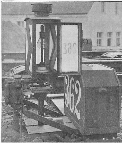
Abb. 6. Elektrisch beleuchtetes Weichensignal mit drehbarer Laterne, Seitenansicht.
