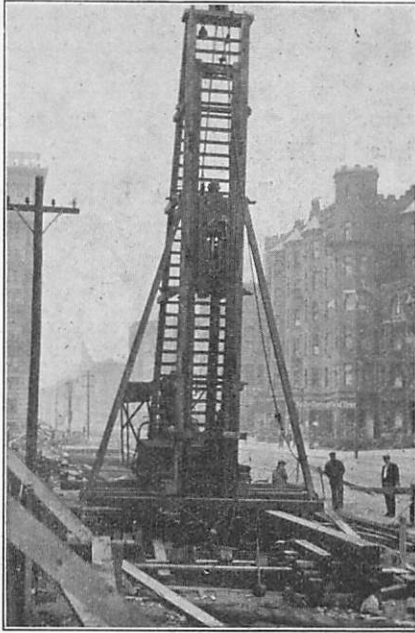
Abb. 2 Untergrundbahn in der Boylston-StraÙe in Boston. Schlagen eiserner Spundwände zur Gebäudesicherung
