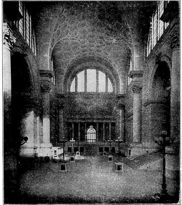
Abb. 8. Blick in den Hauptwartesaal.
