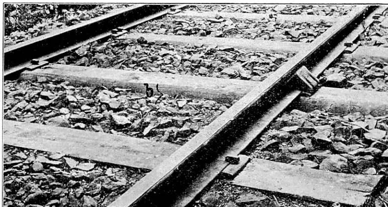
Abb. 17. Nachträglicher Einbau des Stöckels. Der Schotter zeigt bei b, daß die mit dem Stöckel ausgerüstete Schiene in ihrer ganzen Länge gegen das Wandern gewirkt hat.
