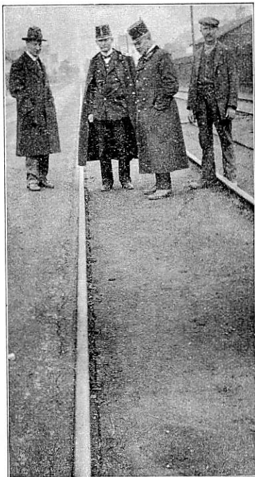
Abb. 5. Wirkung der kippenden - Querkräfte in der Geraden.
