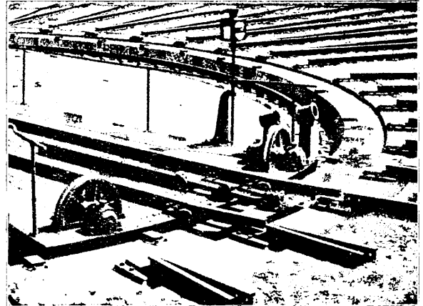
Abb. 2. Zunge gehoben, Scheibe entriegelt, Drehwerk frei.
