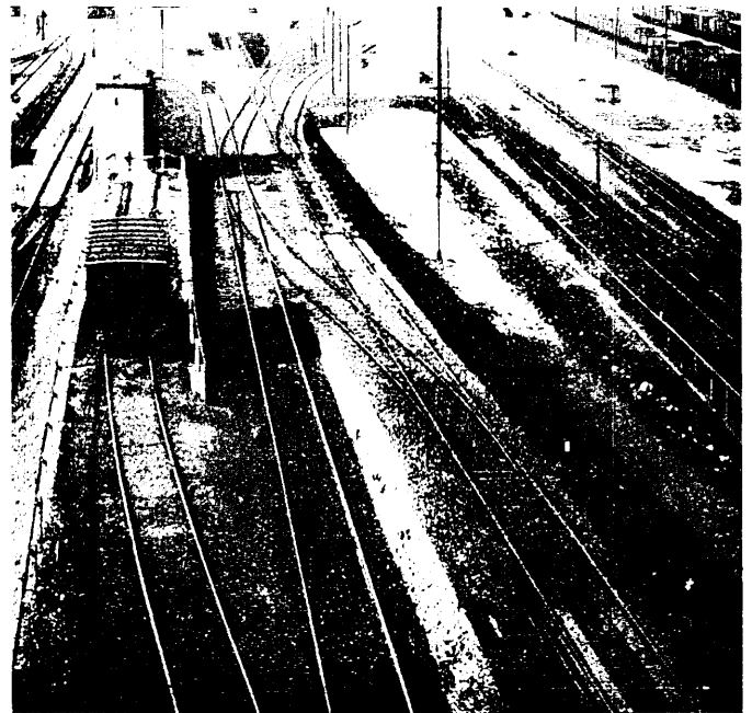
Abb. 6. Gesamtanordnung der Gleisbremse „Thyssenhütte“ in Köln-Nippes mit Ablauframpe und Richtungsgleisen.
