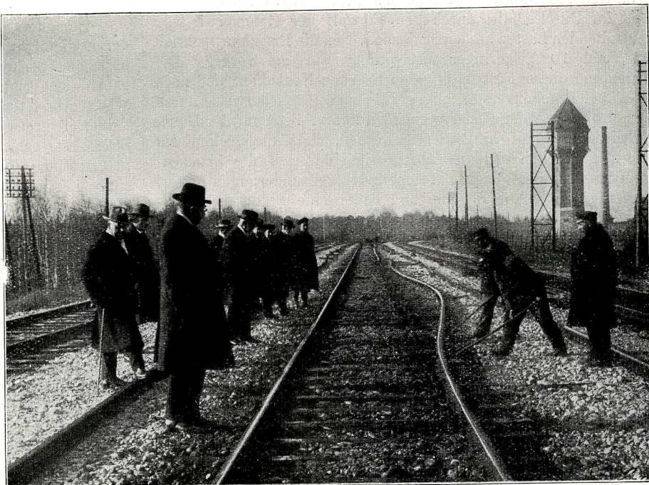
Abb. 8. Einschwenken eines 60 m langen neben dem Gleis geschweißten Schienenstranges in die Schienenachse auf dem Verschiebahnhof Nürnberg von 2 Arbeitern in ca. 3 Minuten.
