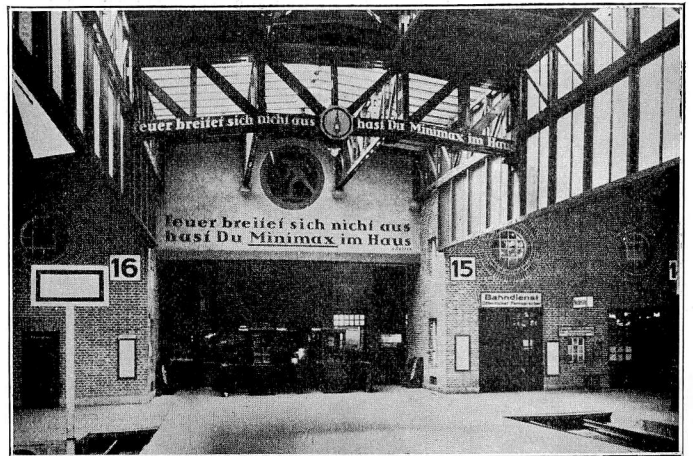
Abb. 7. Gleishallen; Blick gegen die Sperre.
