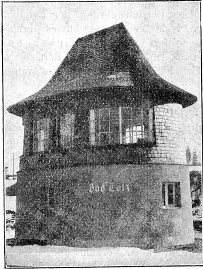
Abb. 2. Mechanisches Wärterstellwerk im Bahnhof Tölz.
