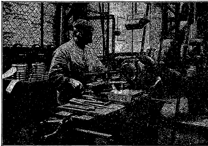
Abb. 14. Drehvorrichtung für Dichtungslinsen.
