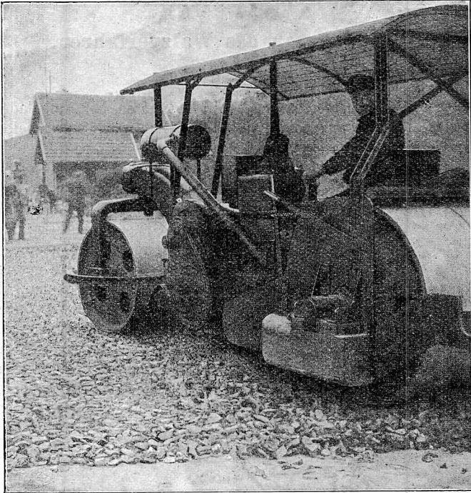
Abb. 2. Tandem-Gleisschotterwalze von der Seite gesehen.
