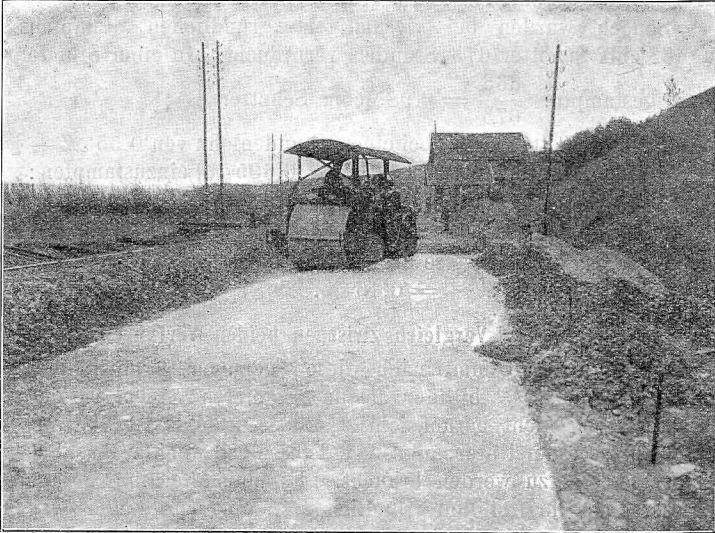
Abb. 4. Abwalzen der Unterbaukrone unter Einbringung einer 4–5 cm starken Sandbettung.
