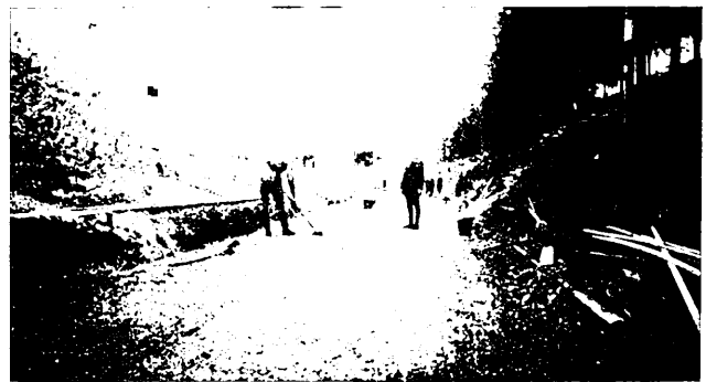
Abb. 9. Schutzschicht Teerasphalt (4 bis 5 cm stark) für die wasserdichte Abdeckung bei Brücken (zwischen den beiden Pfeilern).
