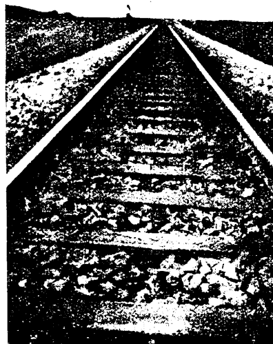
Abb. 4. Mit Triolith getränkte Kiefernswellen in der Versuchsstrecke der Deutschen Reichsbahn bei Küstrin nach Ablauf der zwölfjährigen Gewährzeit. Auswechslung rund 1%.
