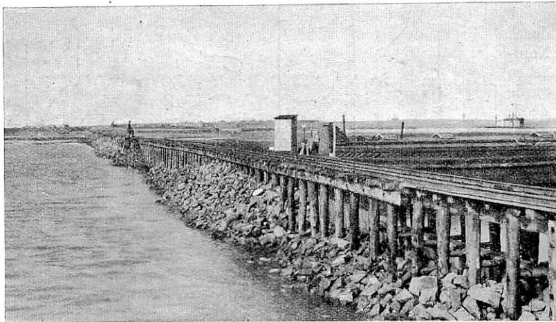
Abb. 4. Mit Steinen eingeschüttete Spundwand.
