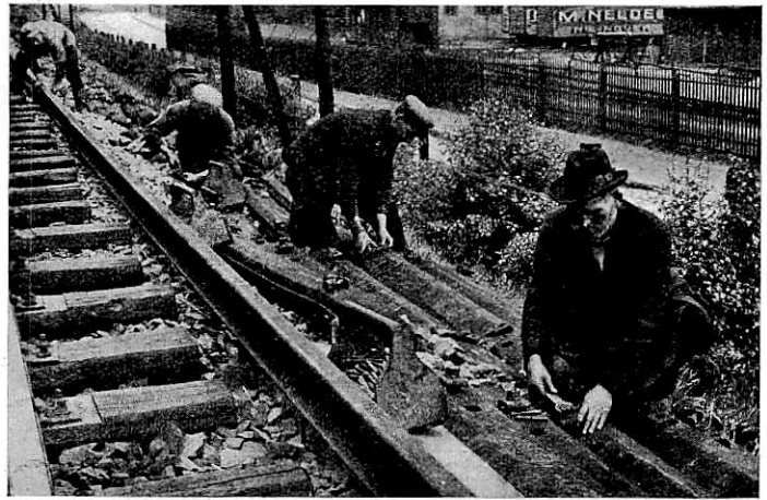
Abb. 9. Einsetzen der äußeren Befestigungsteile.
