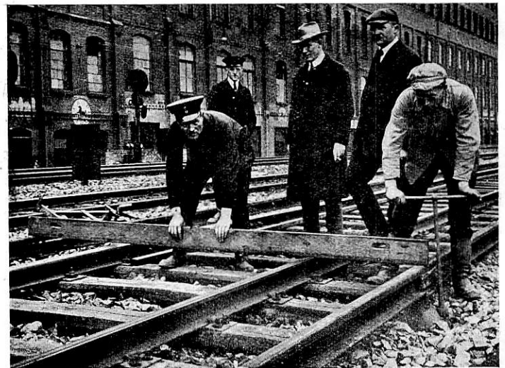
Abb. 4. Ausrichten der Lehrschiene.
