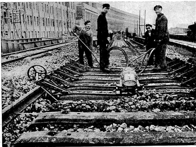
Abb. 11. Stampfen der Bettungsrücken und Verlegen der Schwellen.
