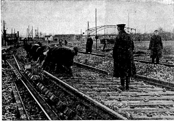
Abb. 12. Aufsetzen der Schienen.
