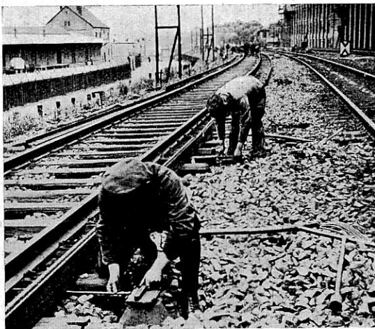
Abb. 3. Verlegen der Richtböcke.
