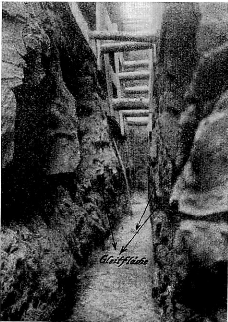
Abb. 3. Längssicker während der Herstellung.
