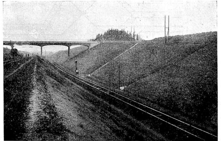
Abb. 4. Zustand der Rutschstelle im März 1927.
