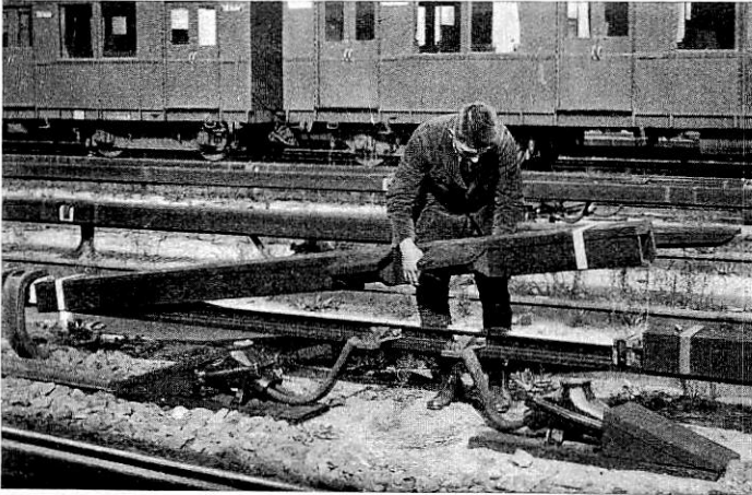
Abb. 3a. Stromschiene mit abgehobenem Schutz und Kabelanschlüssen. (Im Hintergrund Triebwagenzug Bauart 1925.)
