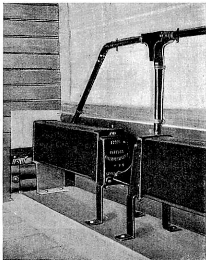
Abb. 9. Verlegung der Leitungen und Anordnung der Heizkörper in den Abteilen 3. Klasse.
