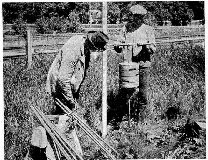
Abb. 2. Die Sonde in Tätigkeit. Belasten der Sonde und Ablesen der Einsenkung.
