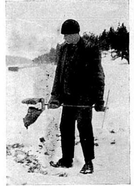
Abb. 5b. Entleeren des Schöpfbohrers.
