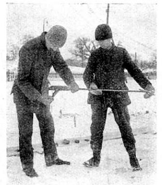
Abb. 3b. Die Bodenprobe wird vom Schraubenbohrer abgelöst.
