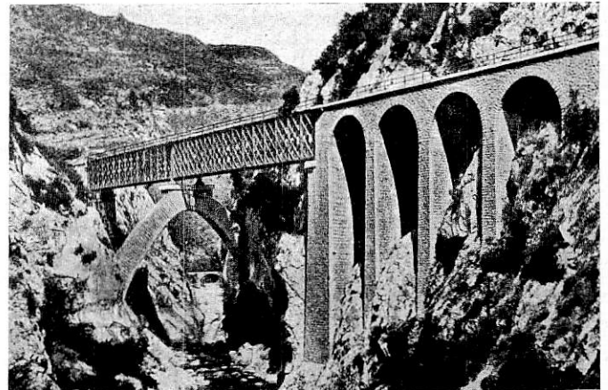
Abb. 5. Viadukt über die Bévéra.
