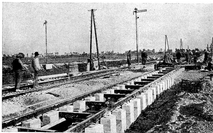
Abb. 9. Bau der Versuchsstrecke Oktober 1928.
