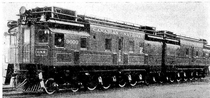
Abb. 11. 2 D 1 + 1 D 2 dieselelektrische Lokomotive der Canadian National-Railway.
