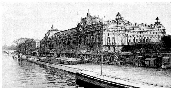
Abb. 9. Bahnhof Quai d'Orsay in Paris der Paris-Orleansbahn.
