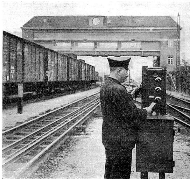
Abb. 6. Linienlautsprecher, Abfragestation am Ablaufpunkt.
