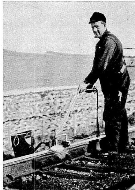
Abb. 4. Erwärmen der Schienenenden auf Härtetemperatur durch Hin- und Herbewegen des Autogenbrenners. Neben dem Schienenstoß die Vorrichtung zum Abschrecken.
