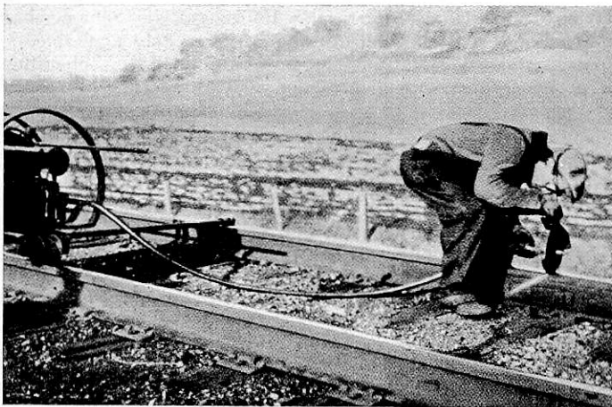
Abb. 2. Tragbare Schleifvorrichtung mit biegsamer Welle an leicht beweglichen Benzinmotor angeschlossen. Brechen der Kanten der Schienenkopfen nach Abb. 3.
