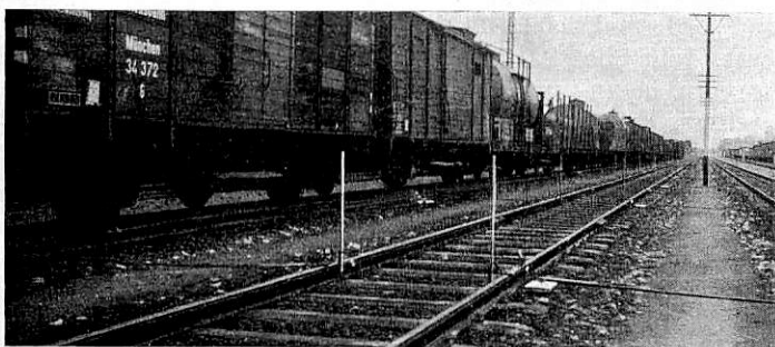
Abb. 7. Versuchsstrecke mit eingebauten Meßinstrumenten.
