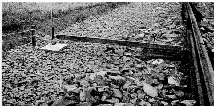
Abb. 6. Verschiebungsmesser.
