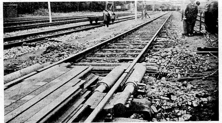
Abb. 3. Eingebaute Gleispresen für einseitiges Drücken. (Die als Widerlager dienenden Lokomotiven sind entfernt.)
