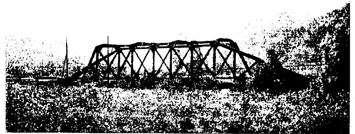
Abb. 9. Ersatzbrücke der Abb. 7 im Landschaftsbild.
