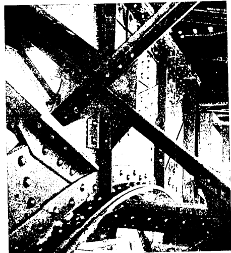
Abb. 4. Eingeschnürtes Ende der mittleren Tragwand des Fischbauchträgers.
