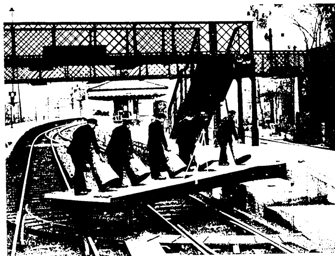
Die Bahnsteigbrücke, halb ausgeschwenkt. Die Bediensteten mit Milchkanne sollen die Abmessungen erkennen lassen.
