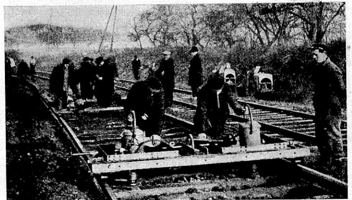
Abb. 2. Bearbeitung der Schwellen mit Hobel- und Bohr- maschinen.
