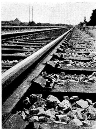
Abb. 7. Verlegter Oberbau im Gütergleis München—Ingolstadt bei Obermenzing.
